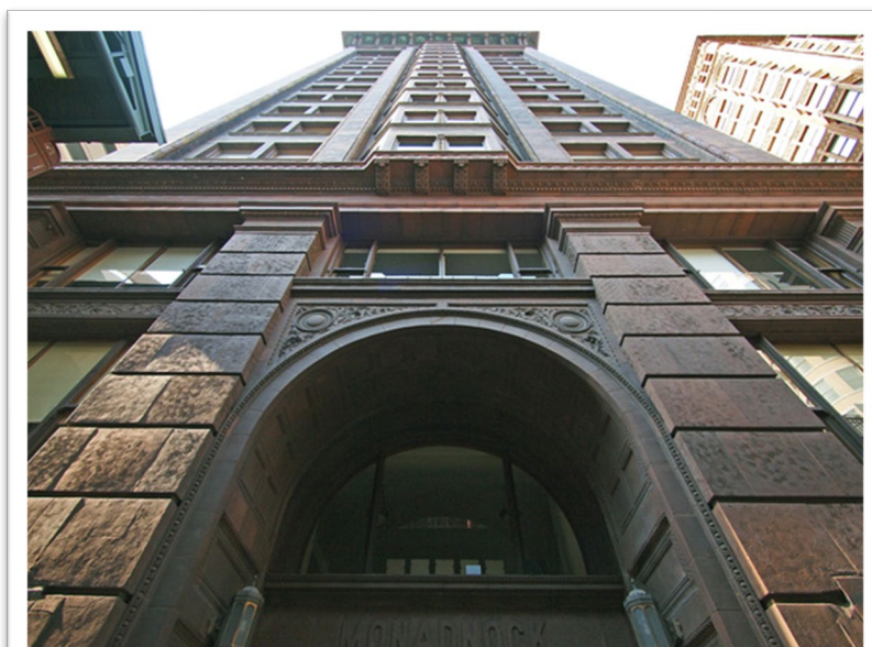
Наружная стена здания "Монаднок"
